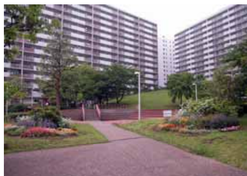
No,1 築山の見えるフロントヤード周辺(33.9%)
